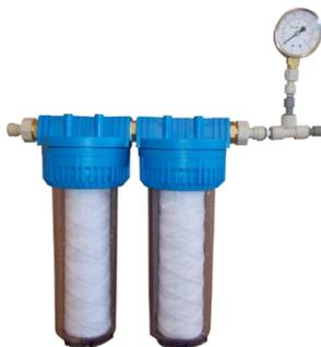
Рисунок 4. Фильтр на трубе подаваемой воды.
