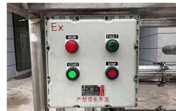
Взрывозащищенный блок управления. Пуск и остановка одной кнопкой. С лампой световая сигнализация о работе и неисправности.
