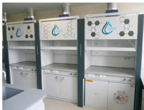
Вытяжной шкаф уменьшенной высоты, для установки в помещениях с низкими потолками
